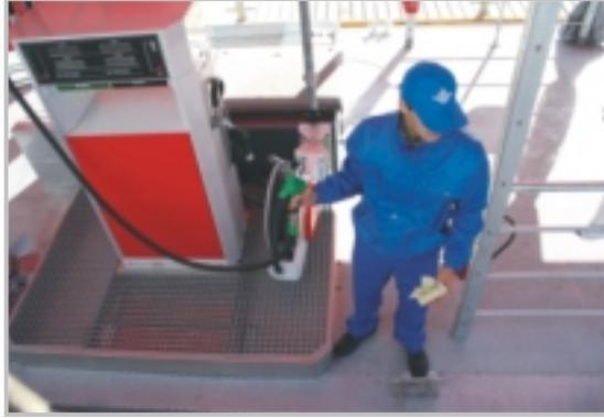
Аварийная ванна для сбора пролитого топлива под ТРК обеспечивает возможность заправки даже канистры и съемных баков водного транспорта, исключая риск загрязнения топливом окружающей среды в случае их опрокидывания.
