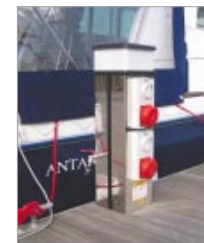
➤ 63amp 3phase interlock sockets.
